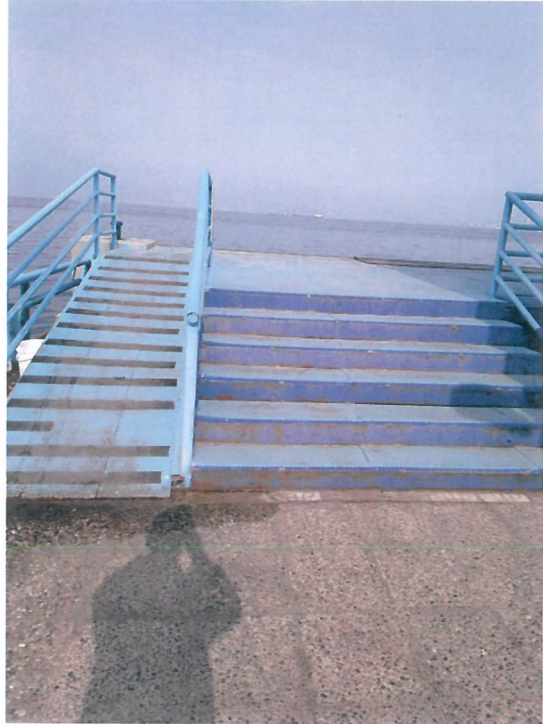
Resim 3.1. Göztepe iskele giriş tel çitleri, sürgülü kapısı, yolcu iniş biniş platformu, engelli rampası, platform zemini ve koruyucu korkuluklar komple boya işleri
